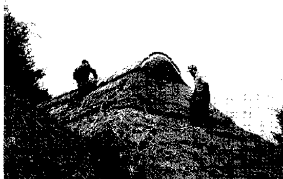
重要文化財旧作田家 屋根棟修理
